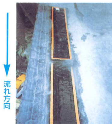
1mの縦ザキ傷をL 6 で修理した写真
